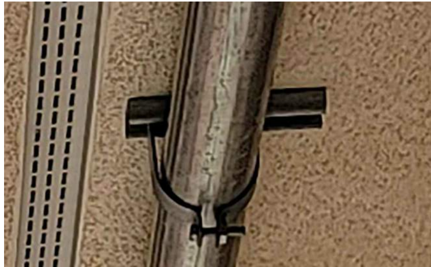
1 EMT CONDUIT SUPPORT
